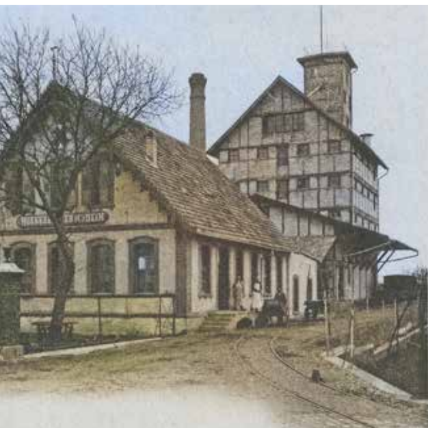
• A l'arrière de la coopérative laitière avec un raccordement à la voie ferrée, le silo à grains de Diebolsheim (à hauteur de Sélestat). © Carte postale ancienne, collection B. S.
